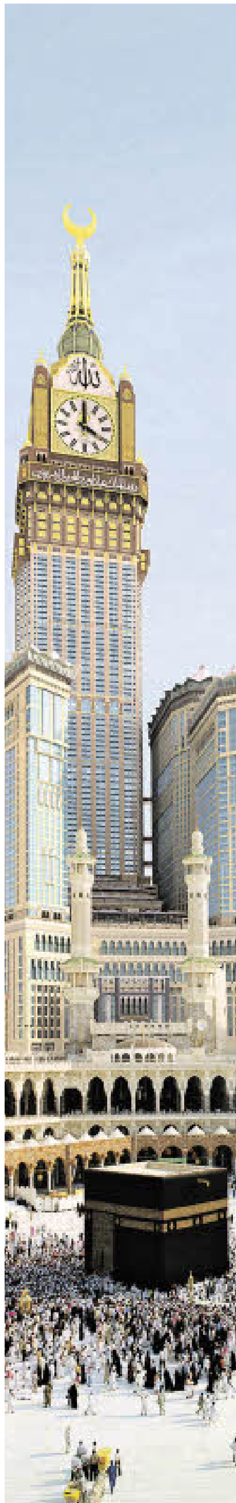
Den Pilgern in Mekka zeigt die Uhr auch noch auf kilometerweite Entfernung die Zeit an – die Technik für das leuchtende Wunderwerk kommt aus Salzburg. Bild: SN/EPA
